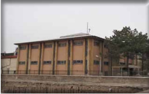
Şekil 4: 9 Kasım 2011 tarihinde meydana gelen Van Depremi'nde hasar gören Van Müzesi ve yakın çevresi. Müzenin hemen bitişiğinde yer alan inşaatın derin temel kazısı, yapının sismik hareketlere karşı incinebilirliğini arttırmış olabilir. Bu örnekte de görüldüğü gibi, risk analizi çalışmalarında yapının yakın çevresinde gerçekleşen risk arttırıcı durumlar gözlemlenmelidir.
