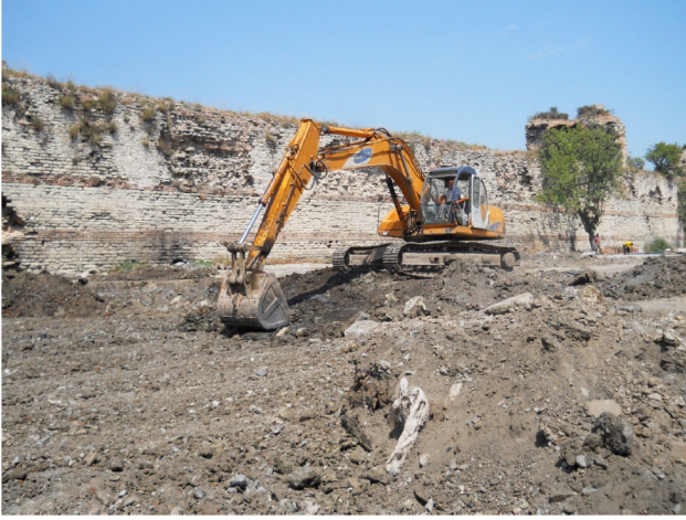
Figure 9 An image showing the excavation (Istanbul Branch of Archaeologists' Association, "Yedikule- Belgrad Kapı Arasında Kara Surları İç Koruma Rekreasyon Projesi")
